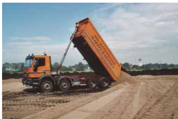
Bau des Bolzplatzes im Jahr 2000
